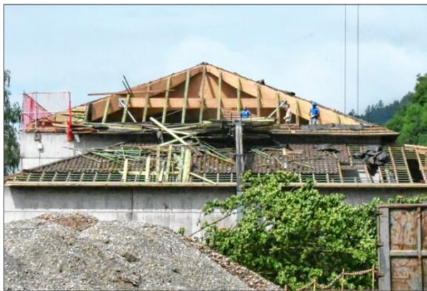
Dem Dach geht's an den Kragen: Das Satteldach auf dem Bad, das später aufgebracht wurde, weil das Flachdach undicht war, wird bald Geschichte sein.
