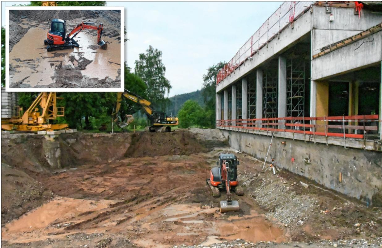
Mehr als 5000 Kubikmeter Erde werden vor dem Gebäude des Kinzigtalbads ausgebaggert, um den Keller zu vergrößern. Vergangene Woche hätte man dort nach dem starken Gewitterregen fast schon ein Freibad eröffnen können (kleines Bild). Die Arbeiter mussten die Baugrube auspumpen, um weiterarbeiten zu können.
