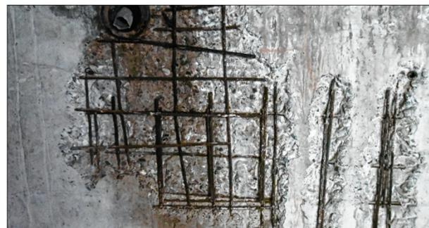
Betonsanierung: Die schadhafte Betonstellen im Kellergeschoss wurden freigelegt und die angerosteten Stahlarmierungen neu beschichtet.
