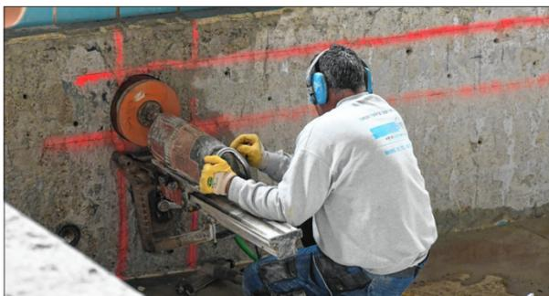
Neuer Treppeneinstieg: Hier werden die Kernlöcher gebaut für den Einbau einer Treppe. Bisher wurde bemängelt, dass man nur über Leitern ins Hallenbadbecken kam.
